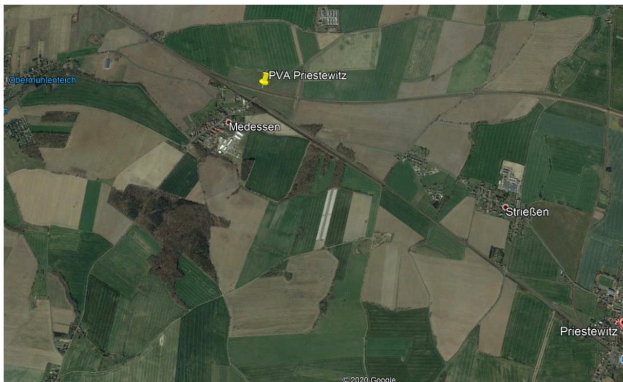
Abbildung 1: PV-Anlage (gelb markiert) in Medessen (OT Priestewitz) (Quelle: Google Earth)
