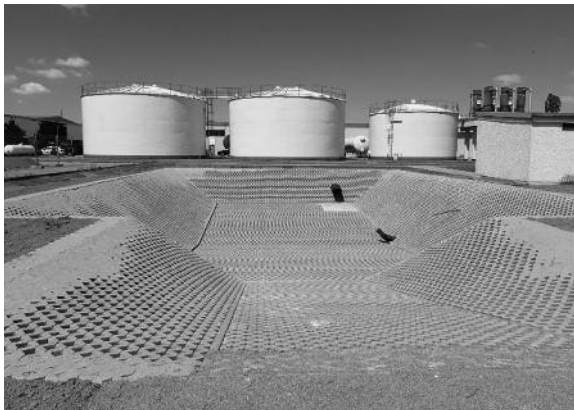
Ein Schlammbecken wurde in diesem Jahr bereits saniert.
