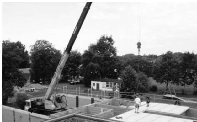
24.7.2014 Verlegung der Dachdecke auf dem Sozialtrakt
