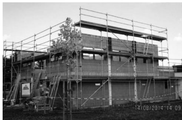
14.8.2014 Mauerwerk für den Turnmehrzweckraum
